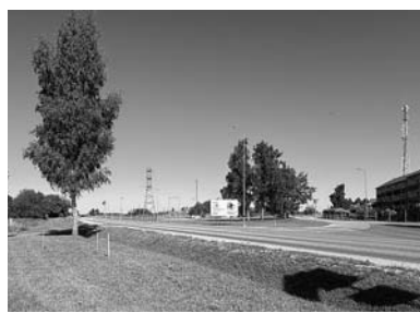
Pirmajā kārtā paredzēts izbūvēt Limbažu ielas posma savienojumu no Gaujas ielas līdz Daugavas ielai, kā arī izveidot rotācijas apli Daugavas ielā. Foto autore – Marita Mūze.
