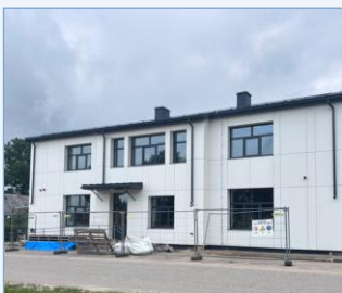
Pašvaldības ēkas Turgus ielā 5, Apē, energoefektivitātes uzlabošana
