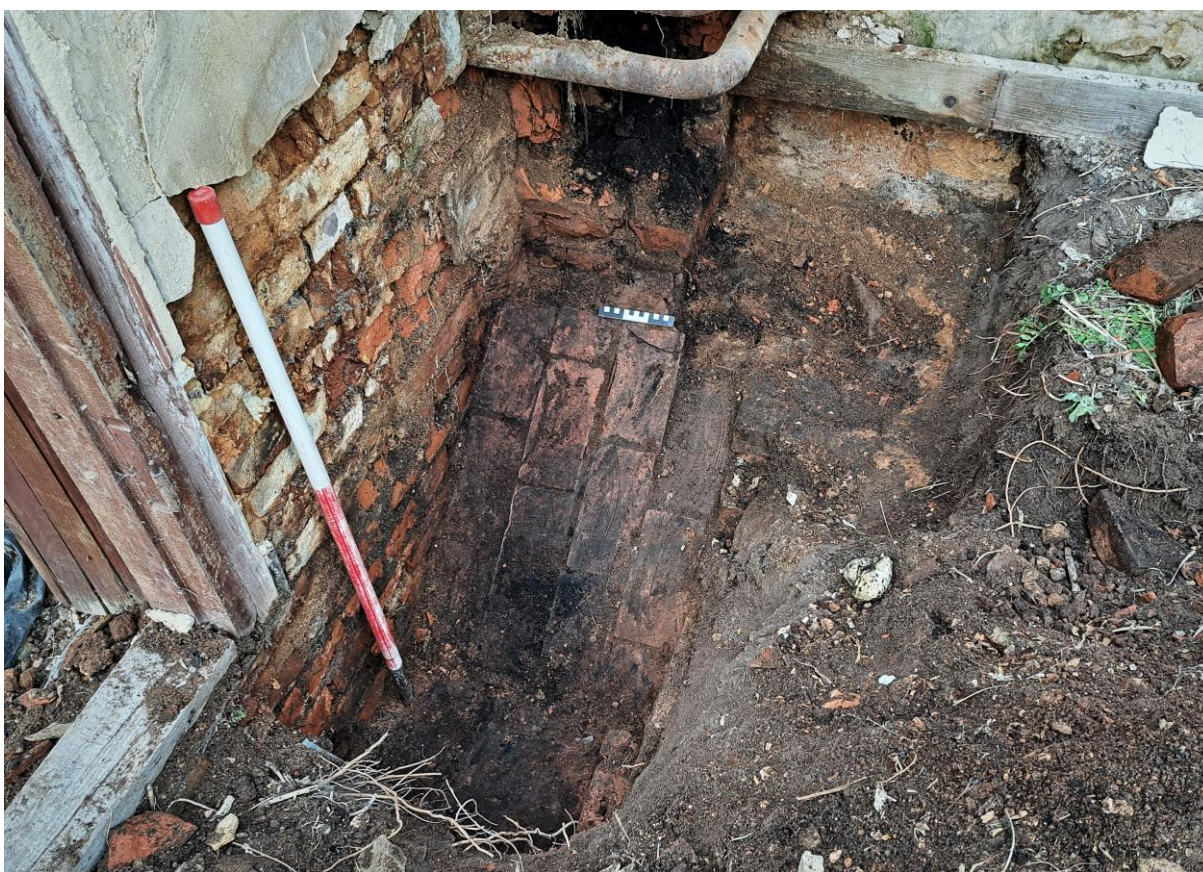
45. att. Šurfs Z3. Zem durvju ailas iedziļinātā dūmkanāla posma pāreja uz pieslēgumu dūmenim.
