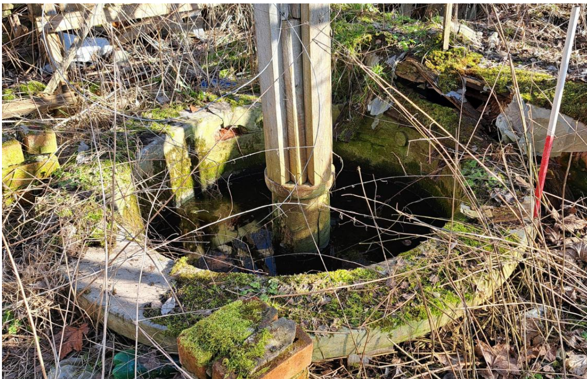
28. att. Ūdens rezervuārs A siltumnīcā. Koka statņa balsts – keramikas caurule
