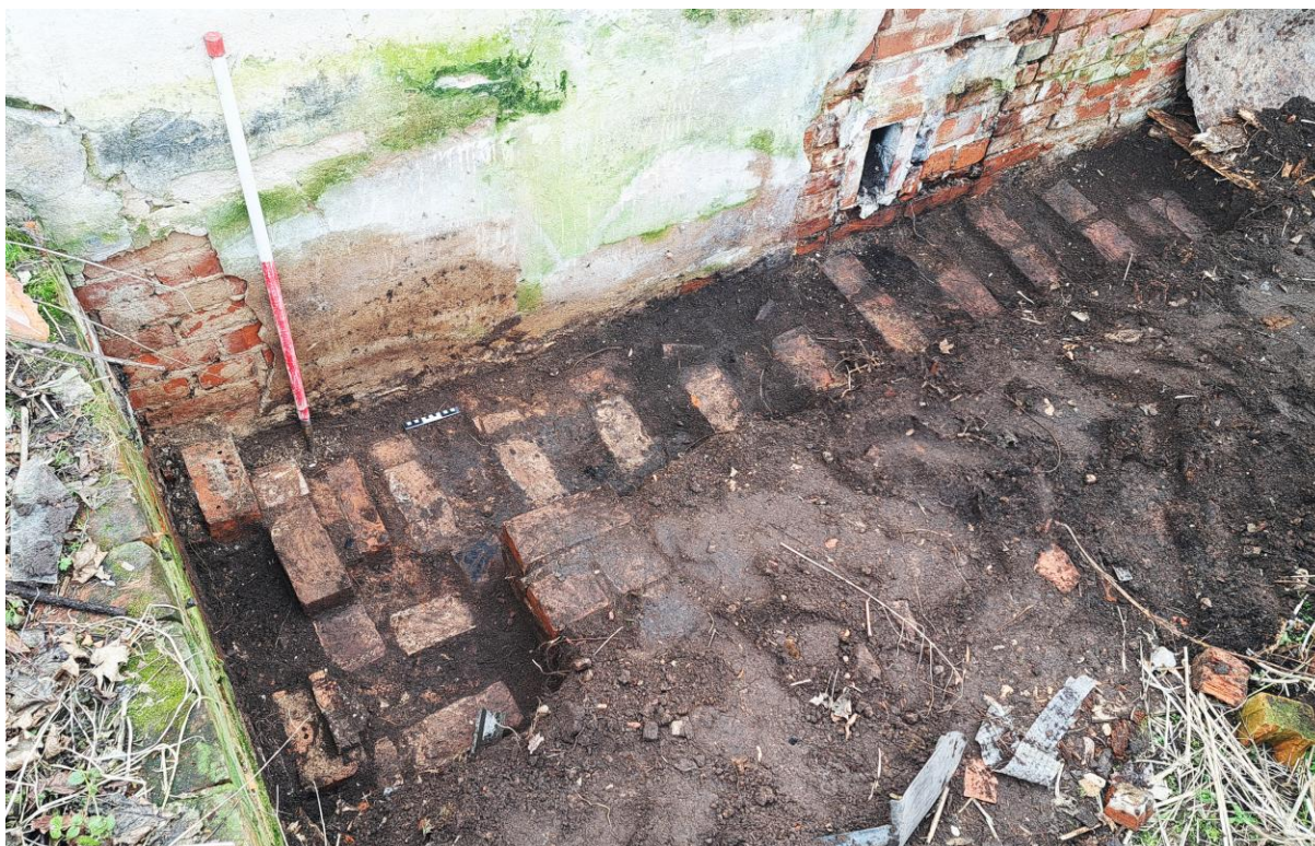
48. att. Šurfs A2. Dūmkanāls pilnībā demontēts. Saglabājušies zem kanāla izliktie pamatnes ķieģeļi.
