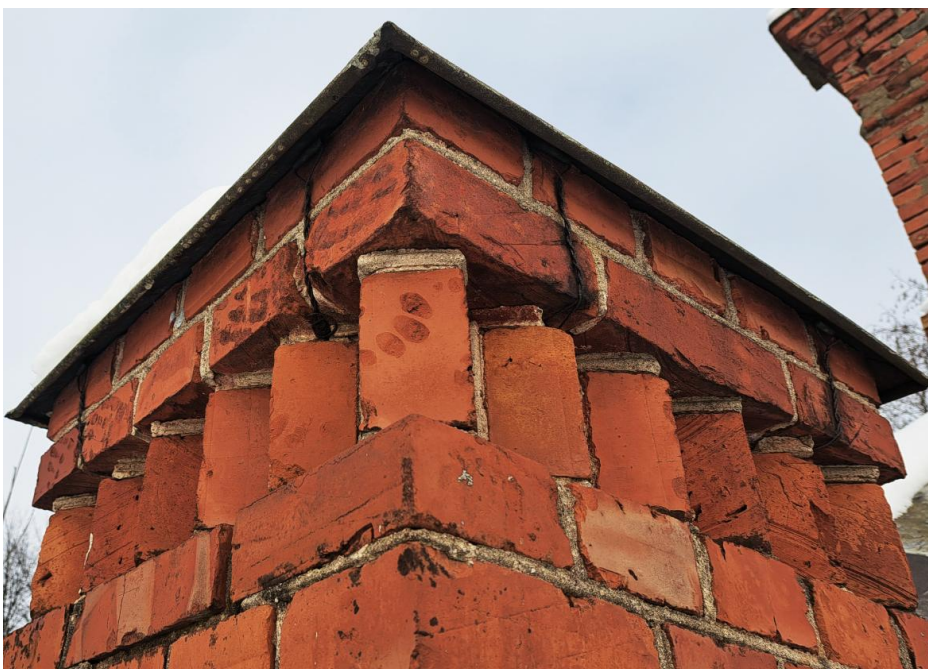
25. att. A siltumnīca, D sienas stūra tornītis. Ķieģeļi ar cilvēka pirkstu iespaidumiem. Skārda jumtiņš pie mūra stiprināts ar metāla stieplēm.
