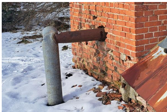
36. att. Z siltumnīca. Daļēji demontēts skārda dūmenis
