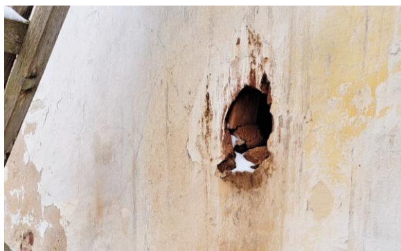
37. att. A siltumnīcas DA sienā sekundāri izveidots atvērums apkures ierīces pieslēgšanai dūmenim
