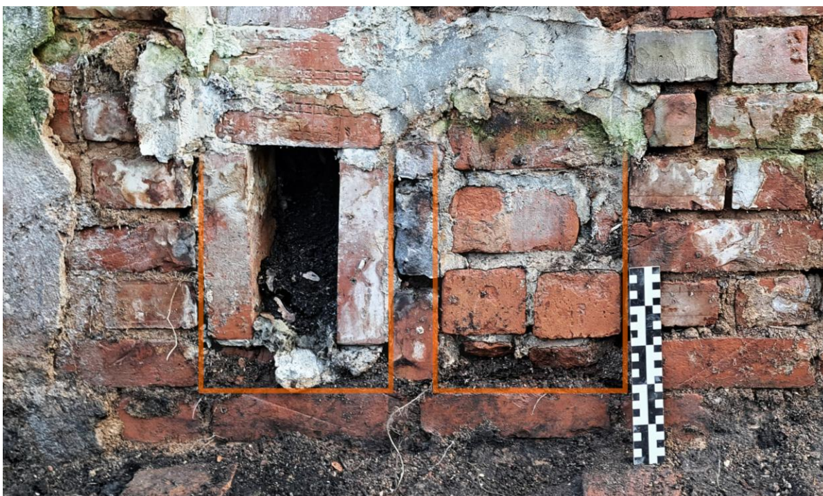
38. att. A siltumnīca, D siena (skatā no telpas). Aizmūrētas pieslēguma vietas dūmenim. Atvērumu izmērs ir pārāk liels, lai to funkciju saistītu ar dūmvada tīrīšanu. Visticamāk, atvērumiem bijuši pieslēgti apkures kanāli.
