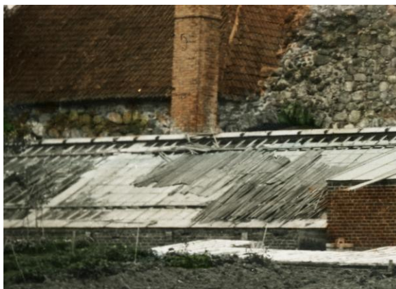
40. att. Uz jumta izklātas bojāto žalūziju atliekas. Ap 1920. gadu uzņemtas fotogrāfijas fragments.
