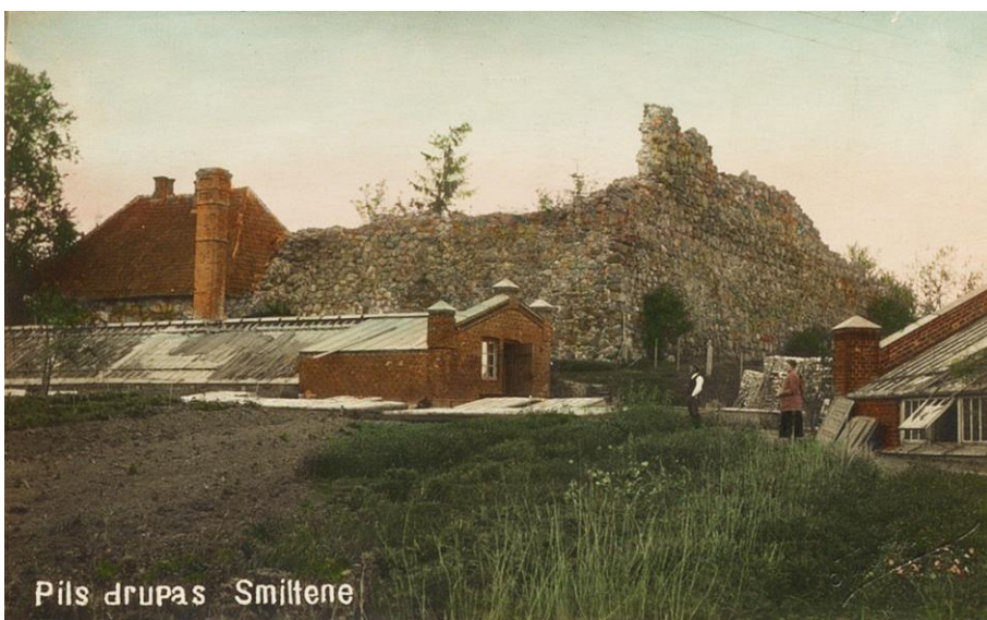
7. att. Skats uz abām siltumnīcām no dienvidiem.
