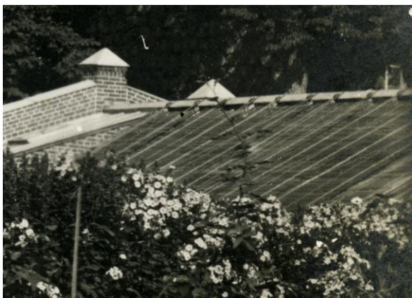
39. att. Z siltumnīcas stikloto jumtu sedz rullo žalūzijas. Fragments no 20. gs. otrajā desmitgadē uzņemta foto.
