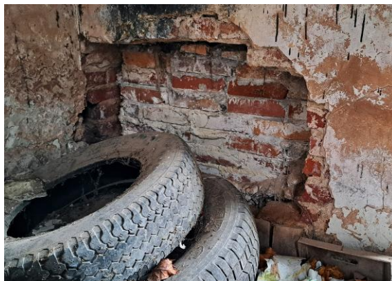
30. att. Z siltumnīca, krāsns vieta siltumnīcas telpas ziemeļu stūrī (skatā no kurtuves telpas). Aizmūrējuma ķieģeļi (25 x 6 cm) likti treknā cementa javā. Atvēruma augstums ~90 cm, platums ~90 cm
