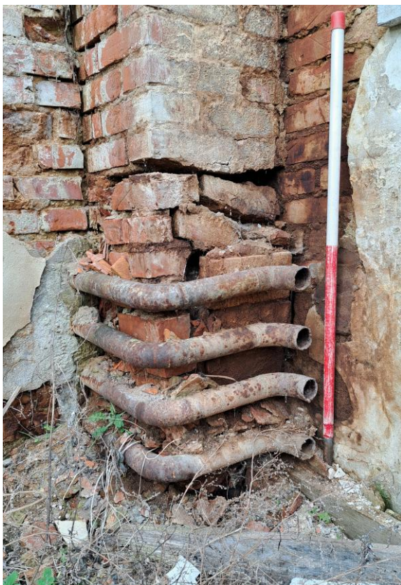
35. att. 20. gs. otrās puses centrālapkures cauruļu fragmenti pie Z siltumnīcas dūmeņa
