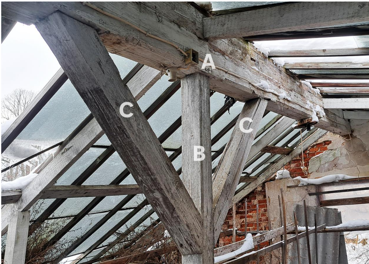
18. att. Jumta konstrukcija Z siltumnīcas DA daļā. Saglabāties sākotnējais kores kopturis (A). Tā apakšējās šķautnes ar dekoratīvu faseti. Balsta statnis (B) un atgāžņi (C) nomainīti 20. gs. otrajā pusē.
