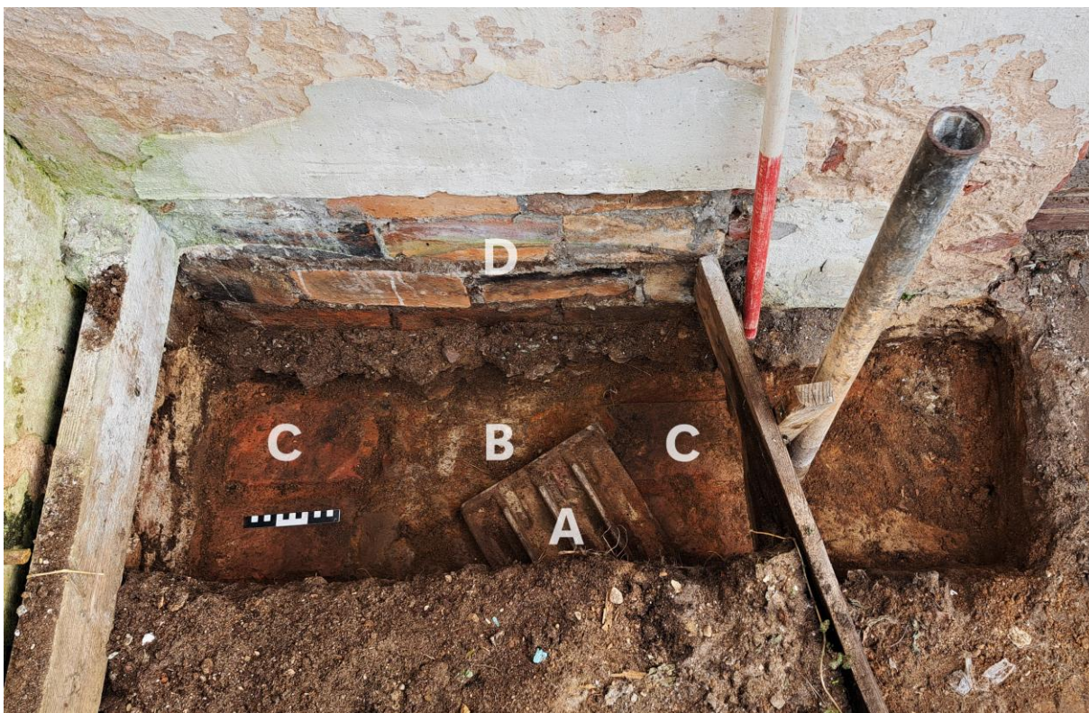
46. att. Šurfs Z4. A – kurtuves reste (ārdi); B – ārdi sākotnējā iebūves vieta; C – kurtuves/dūmkanāla sānu sienu apakšējā ķieģeļu mūrējuma kārtā; D – 20. gs. otrajā pusē aizmūrēts atvērums kurtuvei.
