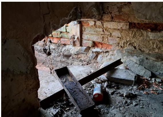
29. att. Z siltumnīca, krāsns vieta siltumnīcas telpas rietumu stūrī (skatā no kurtuves telpas). Augstums no 20. gs. otrajā pusē izbūvētās betona grīdas līdz atvēruma pārsedzei (vidusdaļā) – 60 cm
