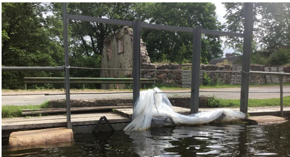
6.attēls Blomes dzirnavezera aizsprosts Blomē, kuru šķērso asfaltētā Dzirnavu iela
