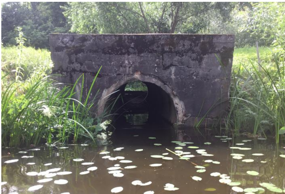
6.attēls. DA daļā konstatēta dzirnavezērā ietekoša caurteka
