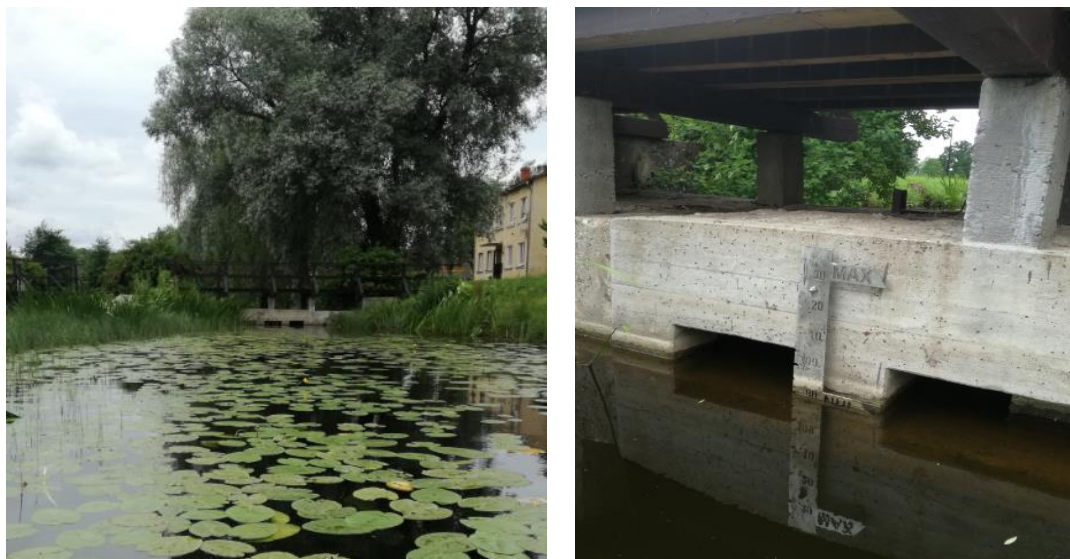
5. un 6.attēls. Derivācijas kanāls un rekonstruētās Tepera ūdenskrātuves slūžas
