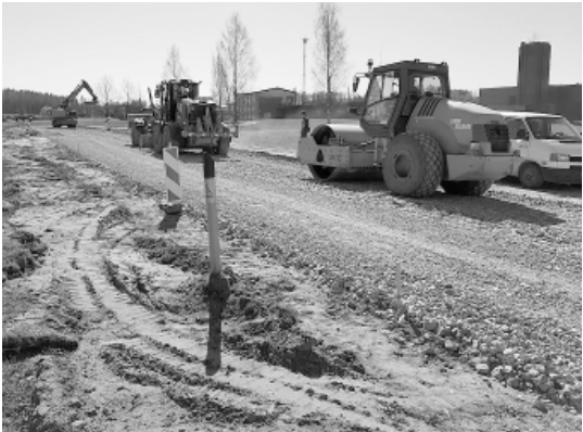
Ceļa „Oktobra iela – Sējumi – Saujas” posma pārbūve.
