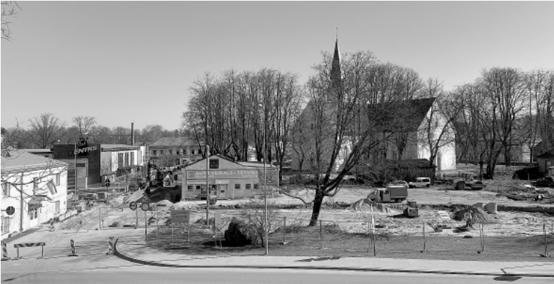
Marijas ielas un Baznīcas laukuma 16A pārbūve.
