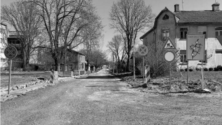
Dakteru ielas pārbūve.
